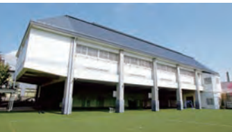
体育館 長さ50m・幅16m(バスケットボ ールコート2面)。
